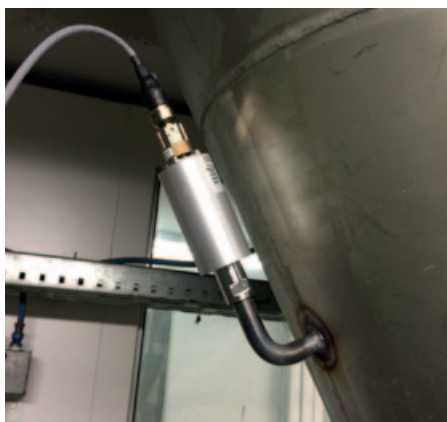
Afb. 4 Ultrasoon geleider op een trechter gelast
